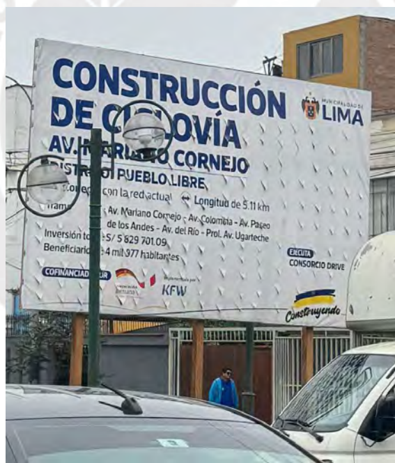
Figura 21. Cartel de obra – Proyecto de ciclovías
