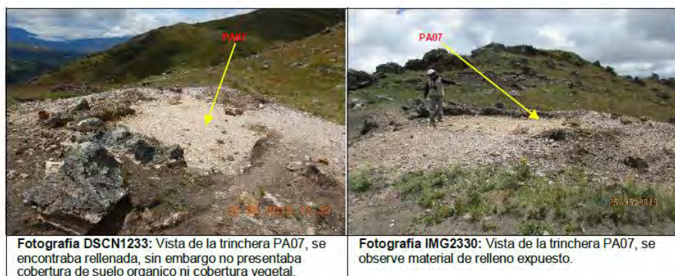
Imagen N° 1: Fotografías de la Supervisión Regular 2019
