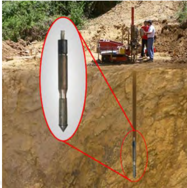
Figura 2-8 Ejemplo de ensayo CPT en ejecución
