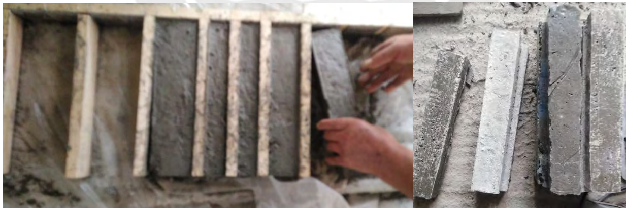
Figura A5 Desencofrado de concreto
