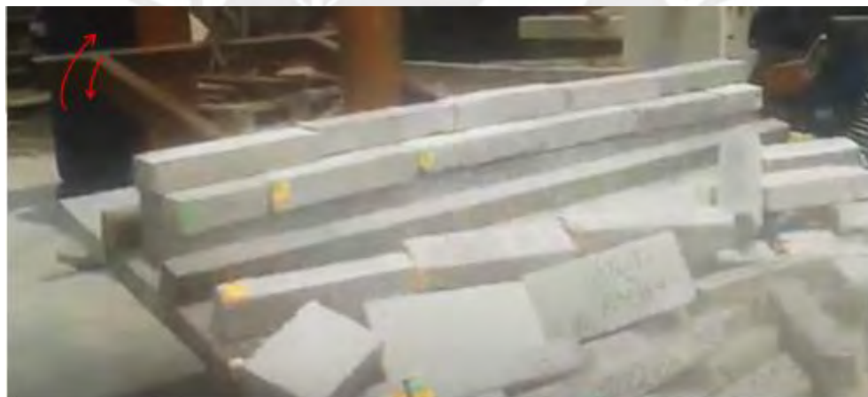
Figura 5.22 Vista frontal de A3V2 (P1) (las flechas en rojo indican el movimiento de la mesa generada por la caída)
