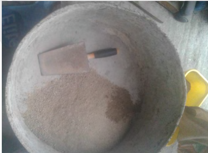
Figura 0 Preparación de concreto
