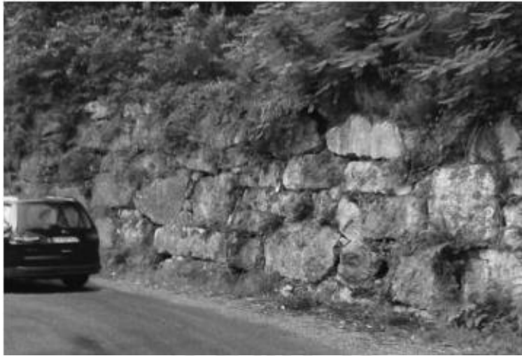
Figura 2.11 Opus Cyclopean en Le Collet-de-Déze, Francia
