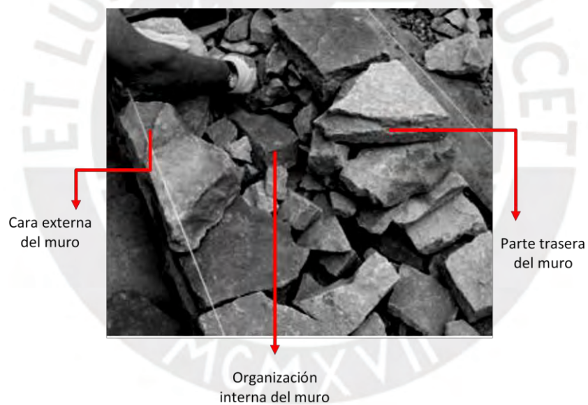
Figura 2.3 Sección transversal de un DSRW
