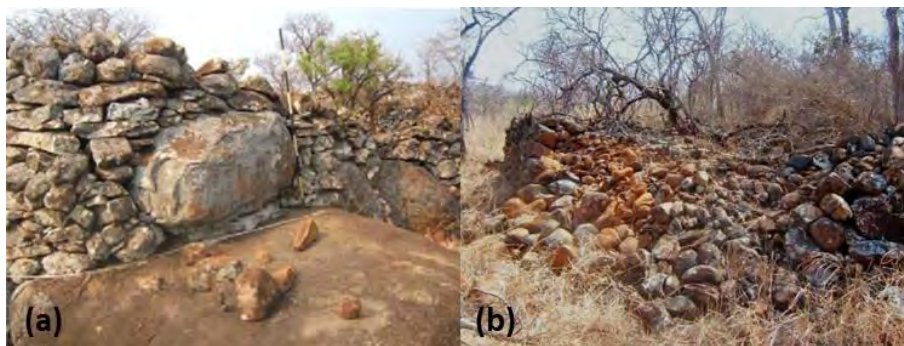
Figura 2.20 a. Volteo de bloques superiores en Ruina 16 de Zimbabwe, b. Colapso progresivo de derecha a izquierda
