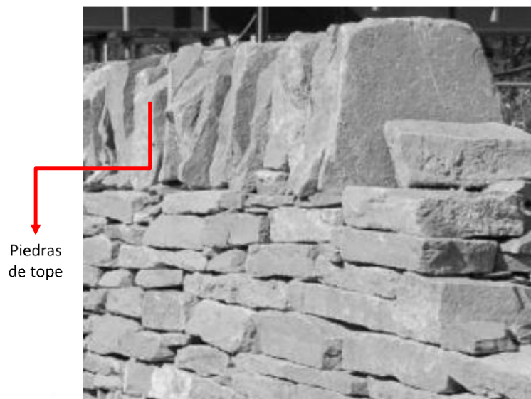
Figura 2.4 Piedras de tope de un muro
