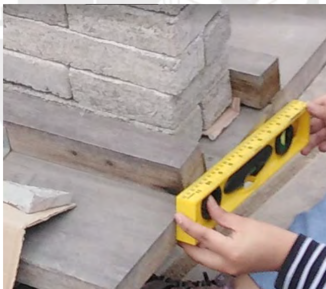
Figura 4.4 Uso de un transportador y un nivel para medir los ángulos
