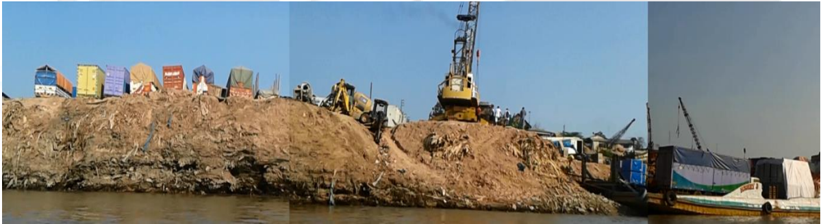
Figura 13. Camiones en espera de ser descargados, grúa castillo y procesos de carga y descarga manual.
