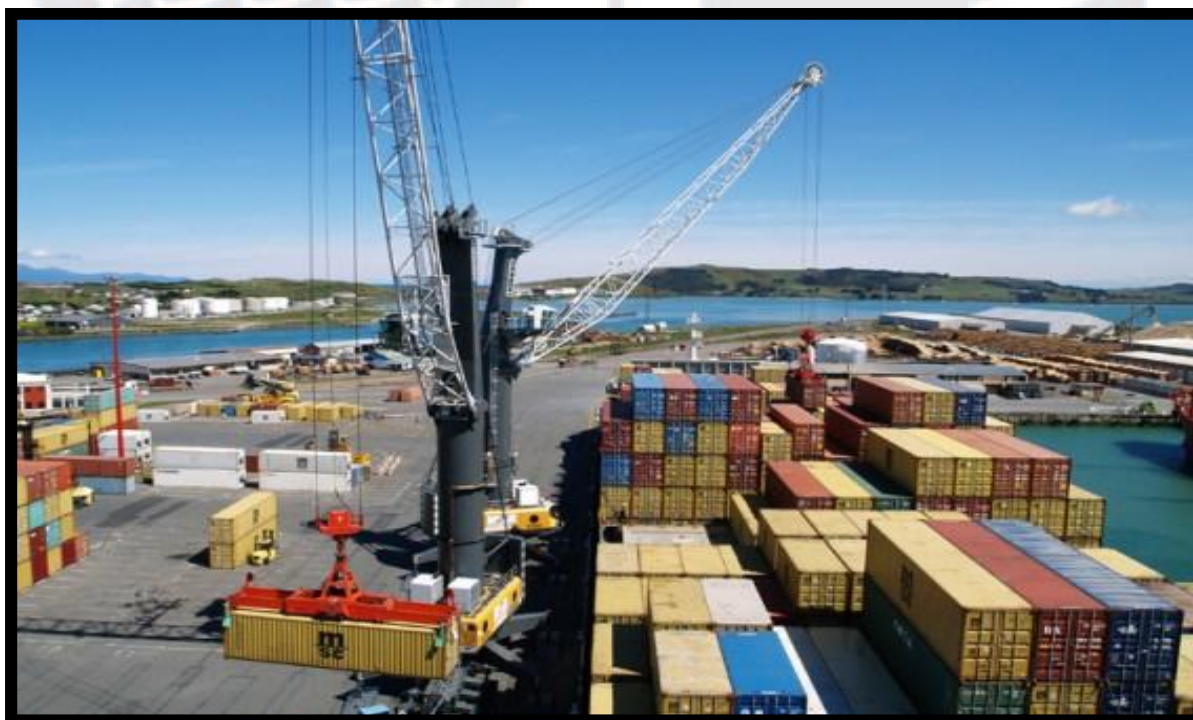
Figura 47. Situación futura del Puerto de Pucallpa. Al año 2025 se contará con tecnología de última generación.
