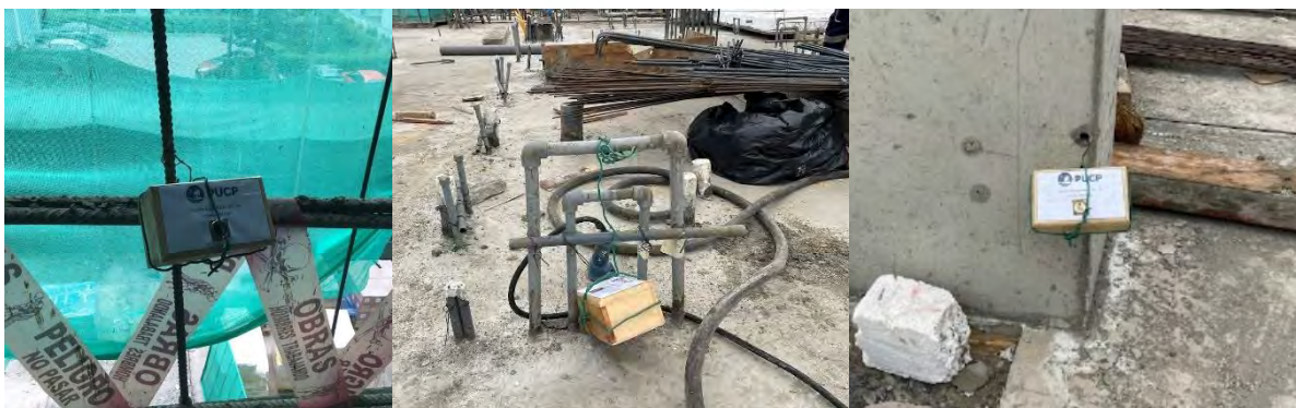
Figura 23. Ubicaciones de las cajas de madera con equipo de monitoreo
