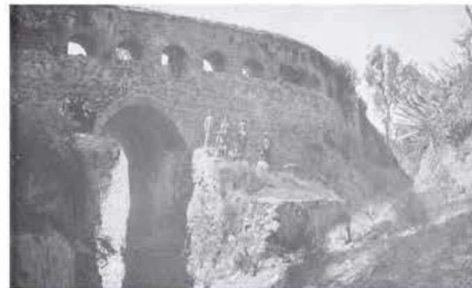
Figura 28. Acueducto Sotoq Checa - Carré 1545
