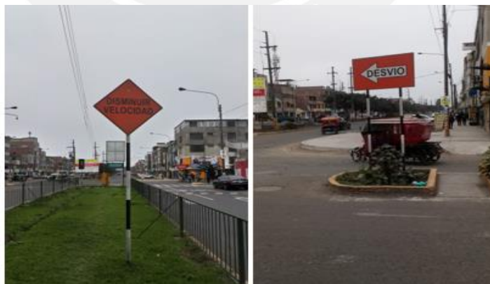
Figura 4.11: Señalización de prevención temporal de construcción Fuente: Propia
