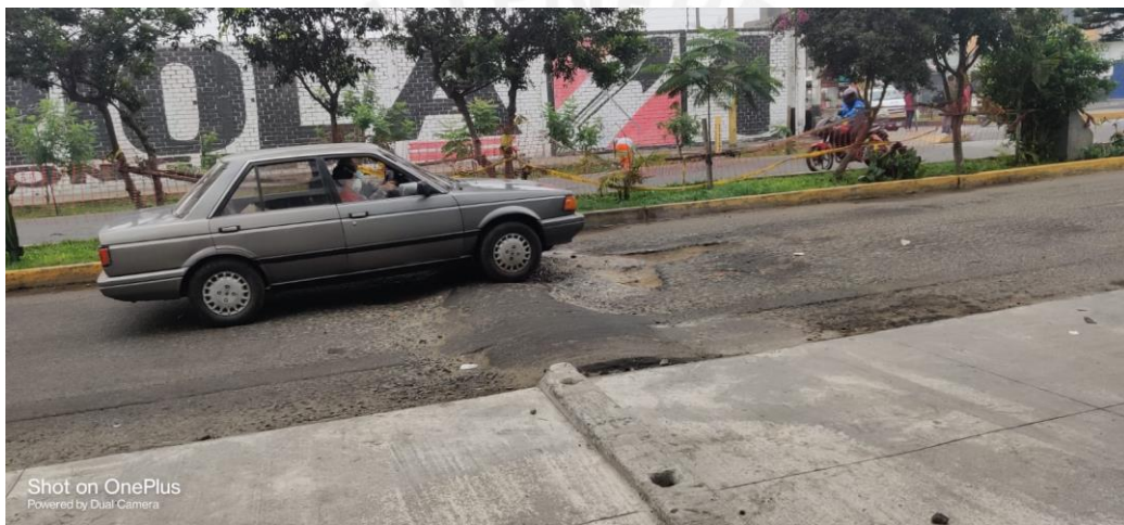
Foto 10: Estado de los pavimentos
