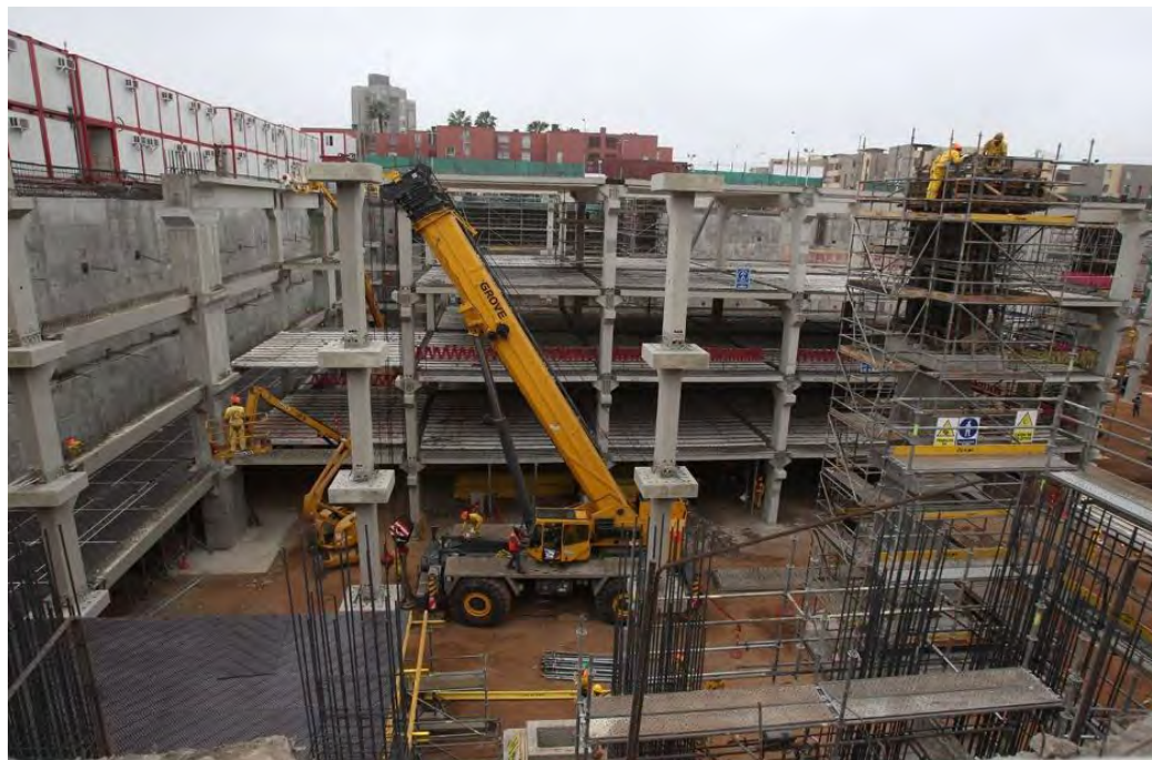
Figura 5: Proceso constructivo de sótanos del Centro de Convenciones de Lima
