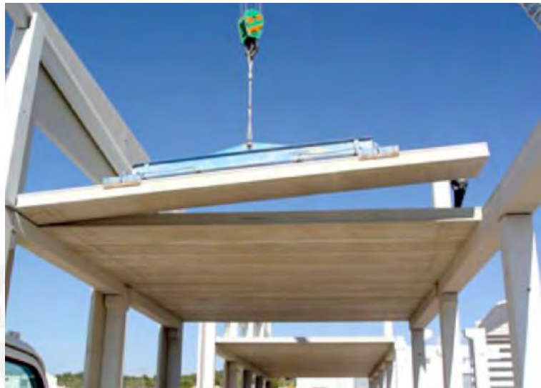
Figura 8: Instalación de placa alveolar en entrepiso (CONCREMAX, s.f.)
