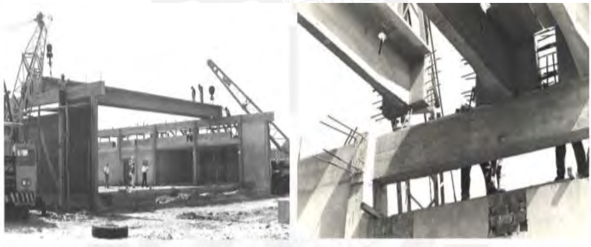
Figura 3: Montaje de vigas T postensadas en “Manufacturas La Libertad”
