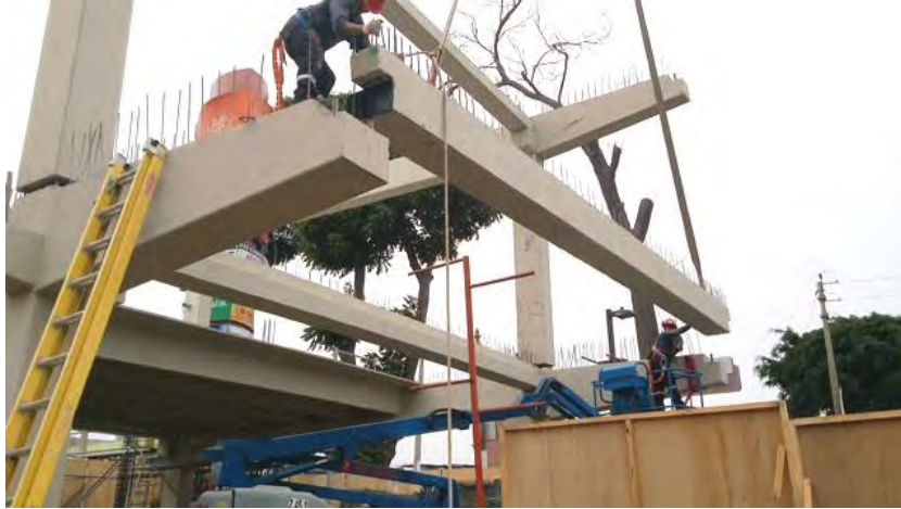
Figura 10: Izaje de viga prefabricada en ampliación de Megaplaza de Chorrillos
