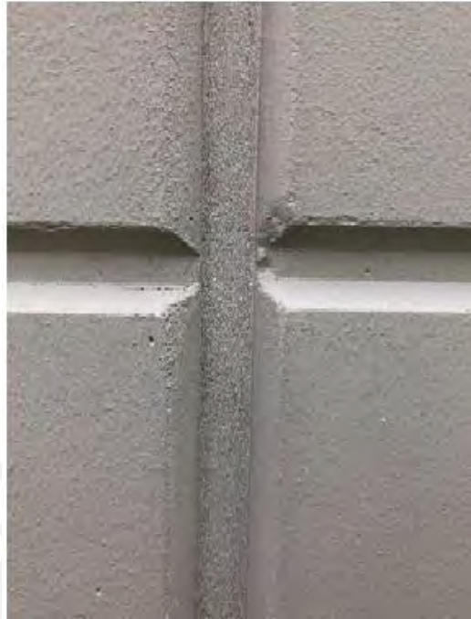
Figura 12: Cinta precomprimida de sellado de juntas verticales
