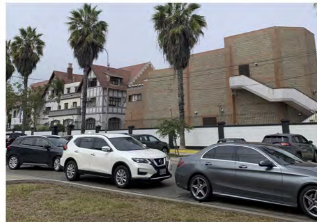
Fotografía de muro ciego permétrico desde la Av. Santa Cruz
