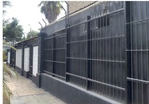
Fotografía de materialidad de muro ciego permétrico del Auditorio
