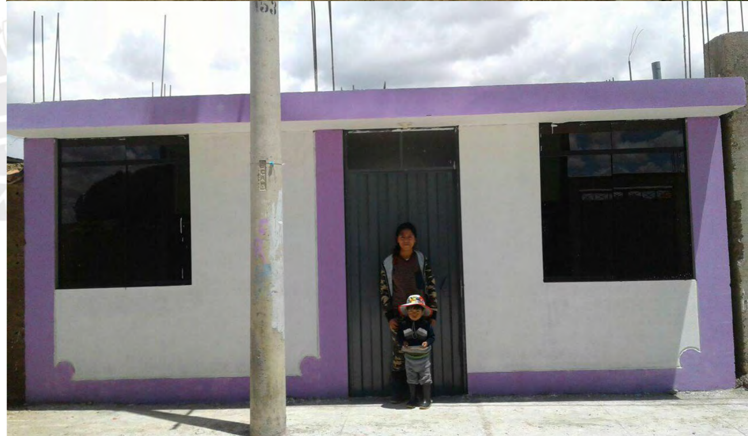
Figura 70 Fotos del módulo Construcción en Sitio Propio. Nota. Fotografías extraídas por el autor del programa Construcción en Sitio Propio (2019).
