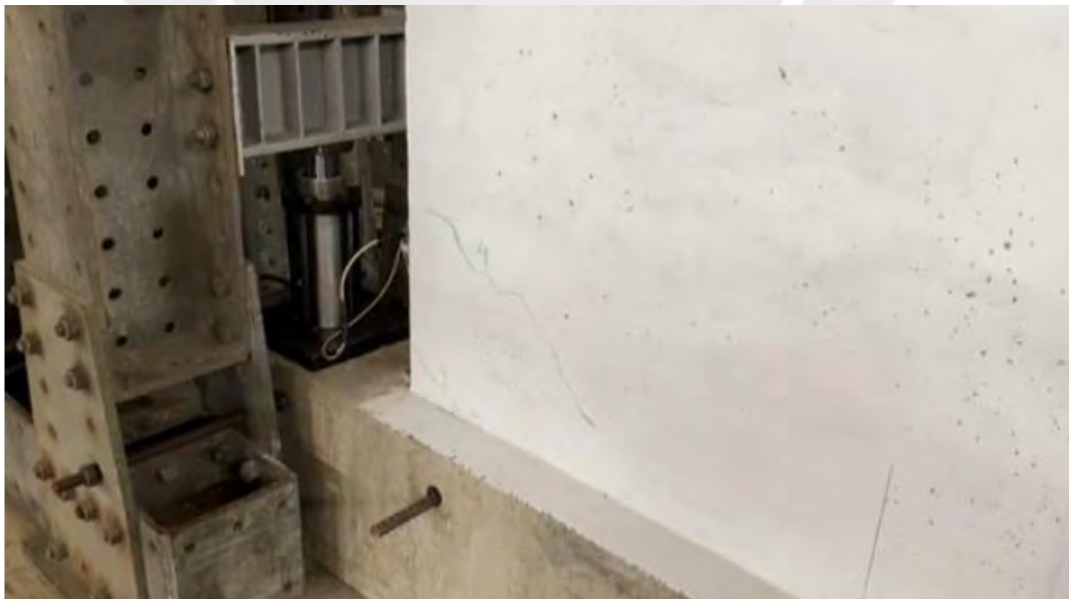
Figura 5.10. Fase 04 (Fisuras de 0.10 mm de espesor)– Amplitud 1.60 mm
