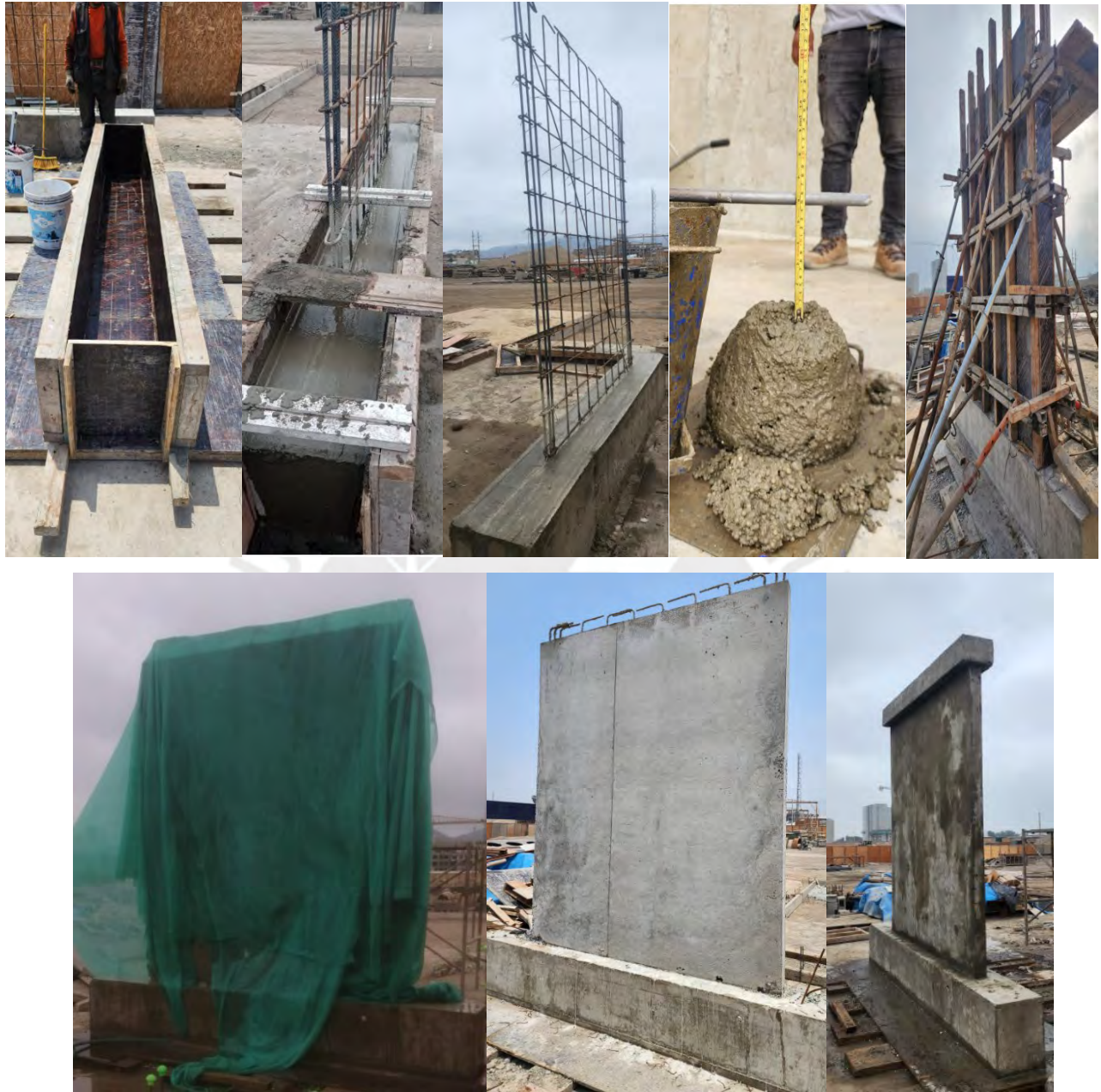
Figura 5.2. Construcción - curado y resane de espécimen para ensayo
