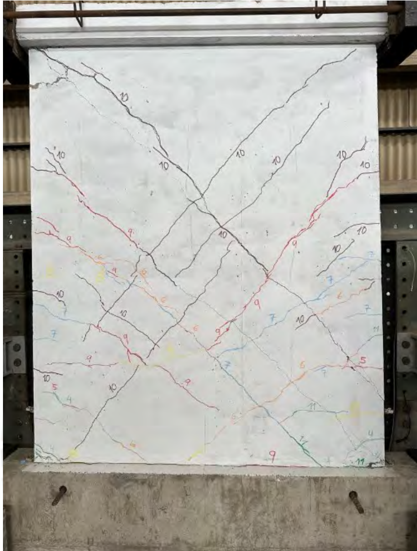
Figura 5.17. Fase 11 (Fisuras de 2.00 mm de espesor) – Amplitud 17.20 mm
