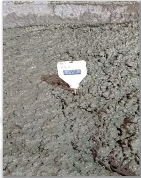
Figura 2.17. Toma de temperatura al concreto ligero– Fuente propia
