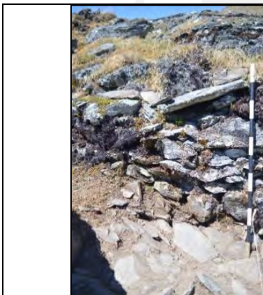
Figura 46: Muros de contención que sirven de protección a la estructura arquitectónica (Fuente: Archivo del PIAP, 2023).
