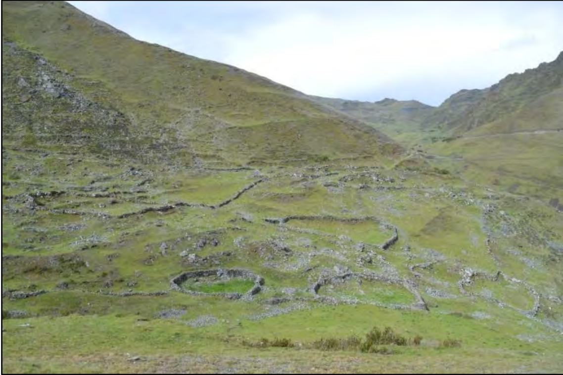
Figura 28: El lado norte del sector se encuentra en malas condiciones de conservación por el uso de las piedras para chacras actuales (Fuente: Archivo del PIAP, 2023).
