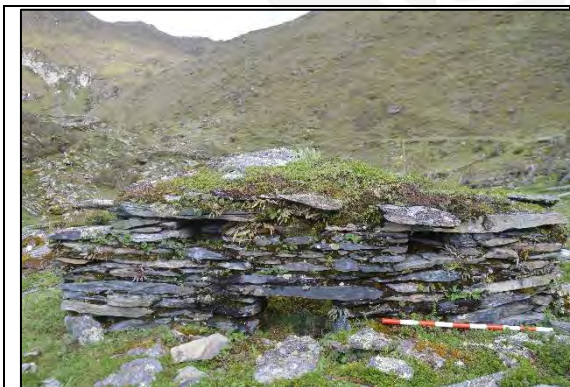
Figura 50: Estructura arquitectónica con dos hornacinas (Fuente: Archivo del PIAP, 2023).
