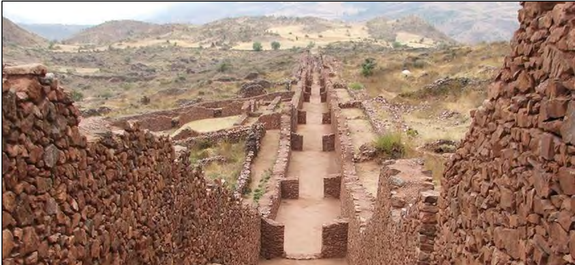
Figura 66: Calle principal en Pikillacta que se dirige de Norte a Sur (Tomado de Vallejo 2020).
