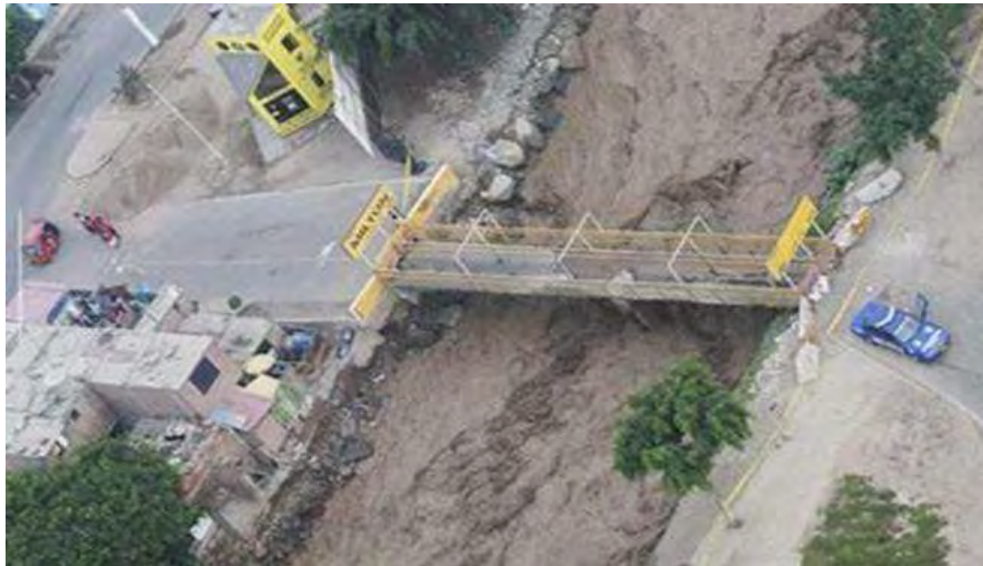
Figura 3: Vista aérea del río Chillón con un caudal aproximado de 30 \text{ m}^3/\text{s} . Se observa un cauce lleno pese a que no se trata de un caudal extraordinario.
