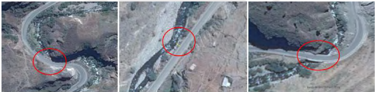
Figura 40: Identificación de tramos vulnerables a posibles riesgos en la ruta de Canta a San José
