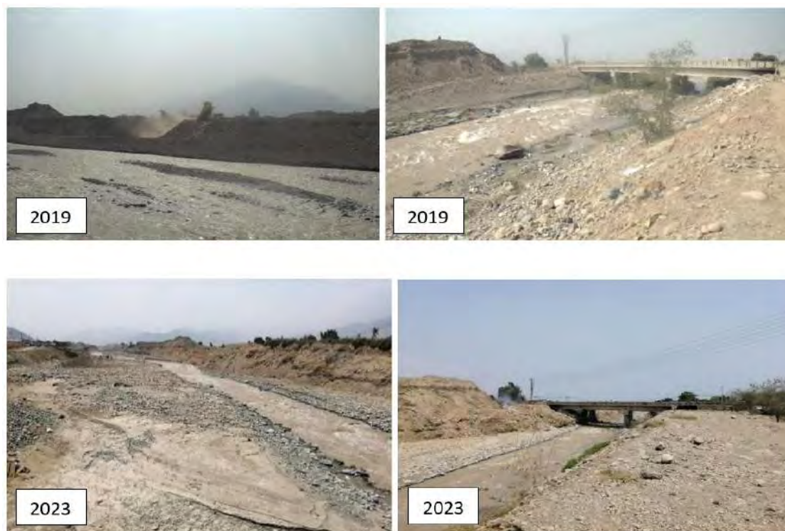
Figura 46: Comparación de desmonte acopiado en el talud del río Chillón, por la zona del puente San Martín entre los años 2019 y 2023
