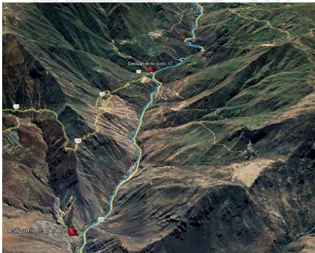
Figura 39: Ubicación de las zonas críticas por deslizamiento 9 y 10
