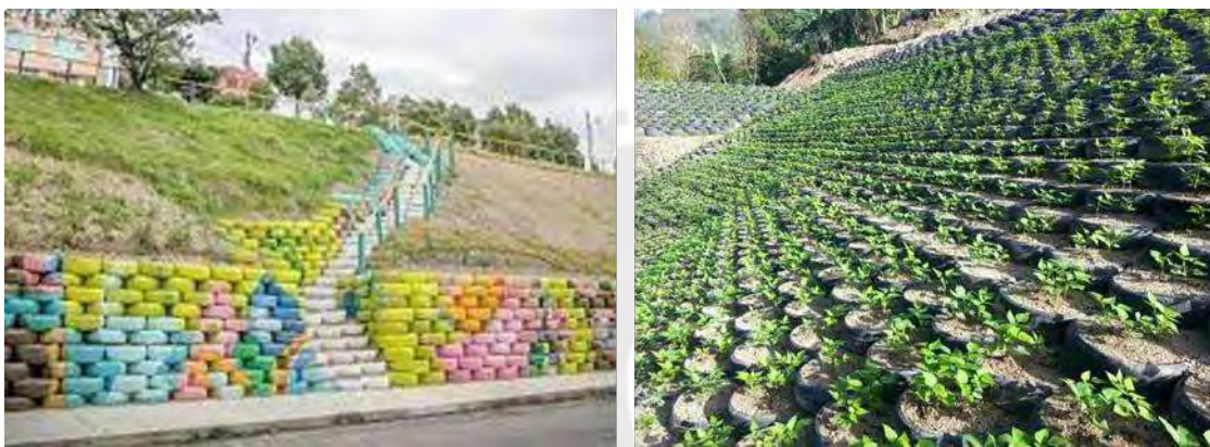
Figura 68: Uso de neumáticos para el reforzamiento de taludes
