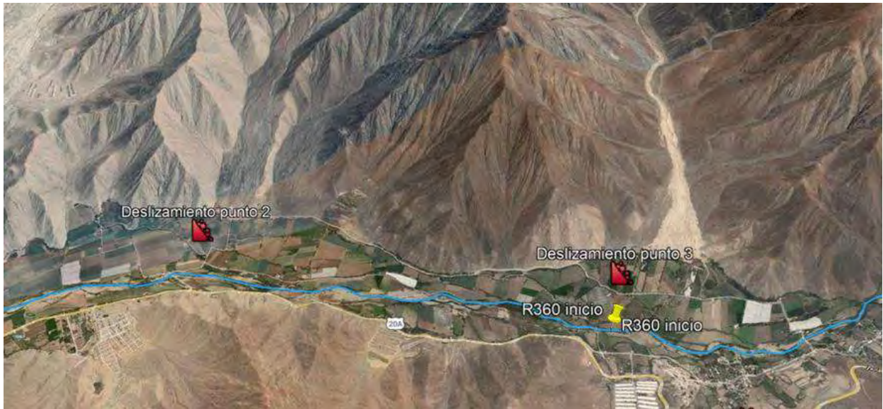
Figura 38: Ubicación de las zonas críticas por deslizamiento 2 y 3
