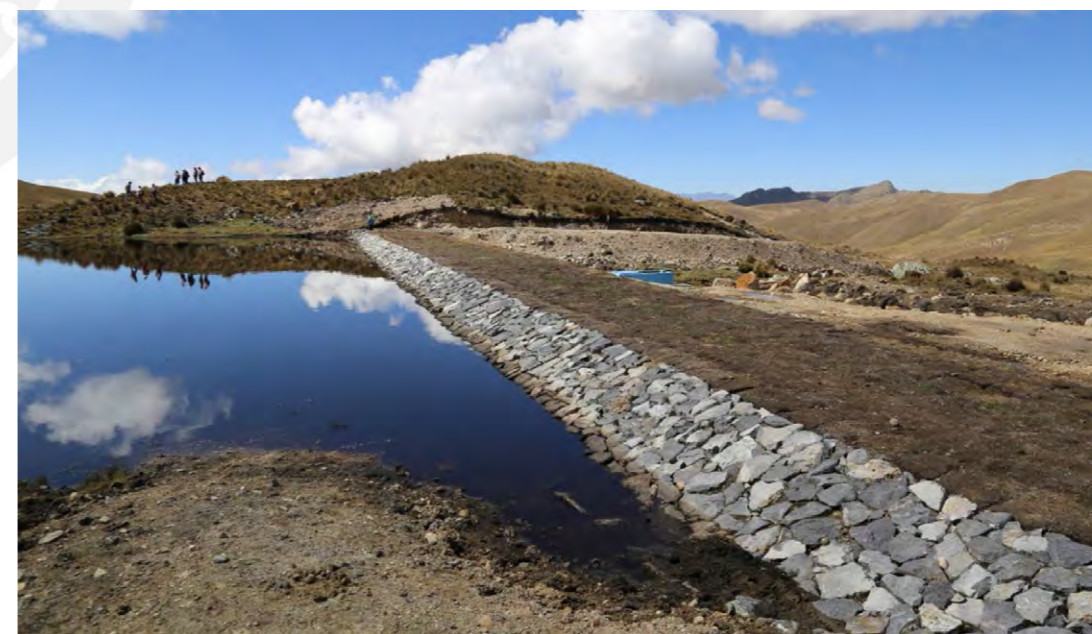
Gráfico 150 Cocha cosntruida con dique de piedra y arcilla Fotografía de Fondo Sierra Azul, 2023
