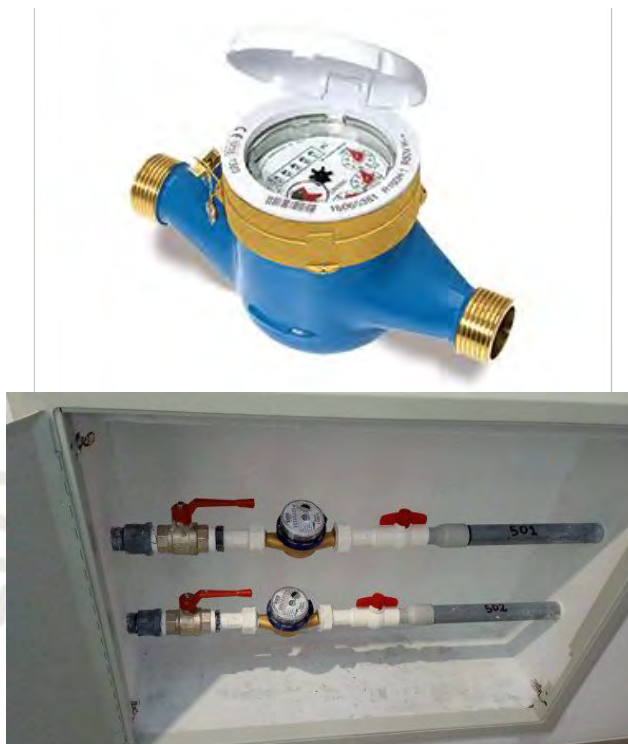
Figura 15: Medidores de agua
