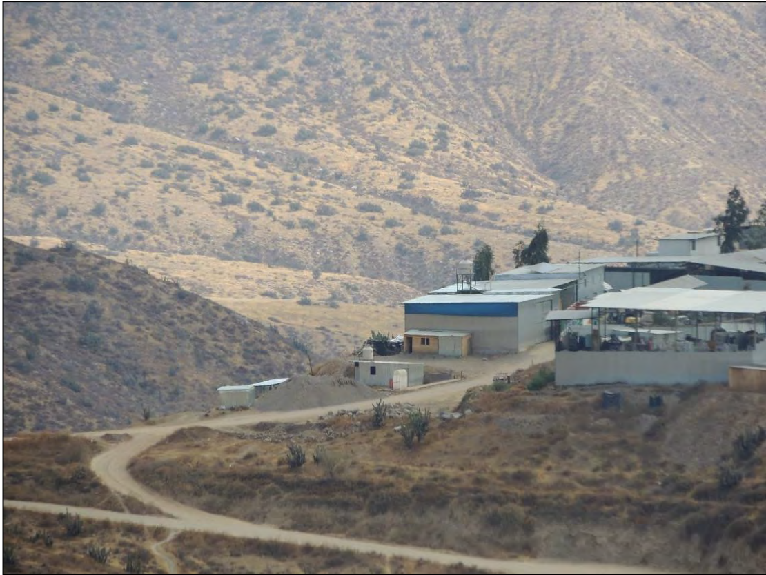
Vista desde el noreste de la entrada a la Planta Minera Comunal y de parte de la Sección 1.
