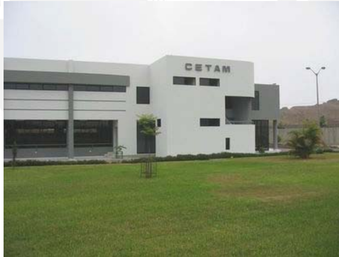
Figura 5.1 Exteriores de la sección de Ing. Electrónica
