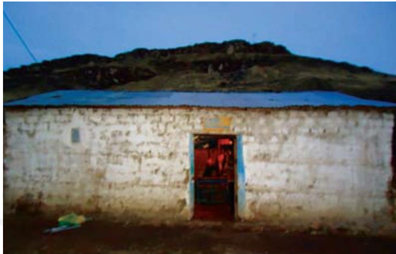
Figura 10: Vivienda típica sin modificación para calefacción. Fuente: CARE Org (Ref. 9)
