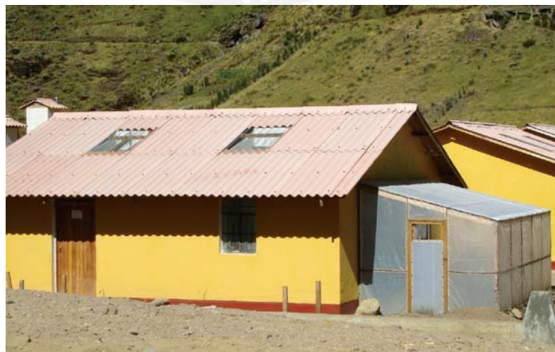
Figura 11: Vivienda con invernadero para calefacción. Fuente: CARE Org (Ref. 9)
