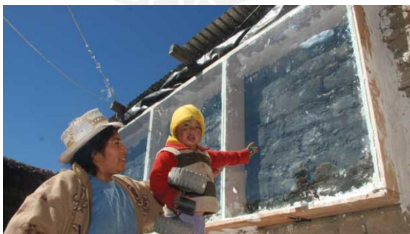
Figura 17: Muro de trombe en vivienda Fuente: Sencico (Ref. 11)
