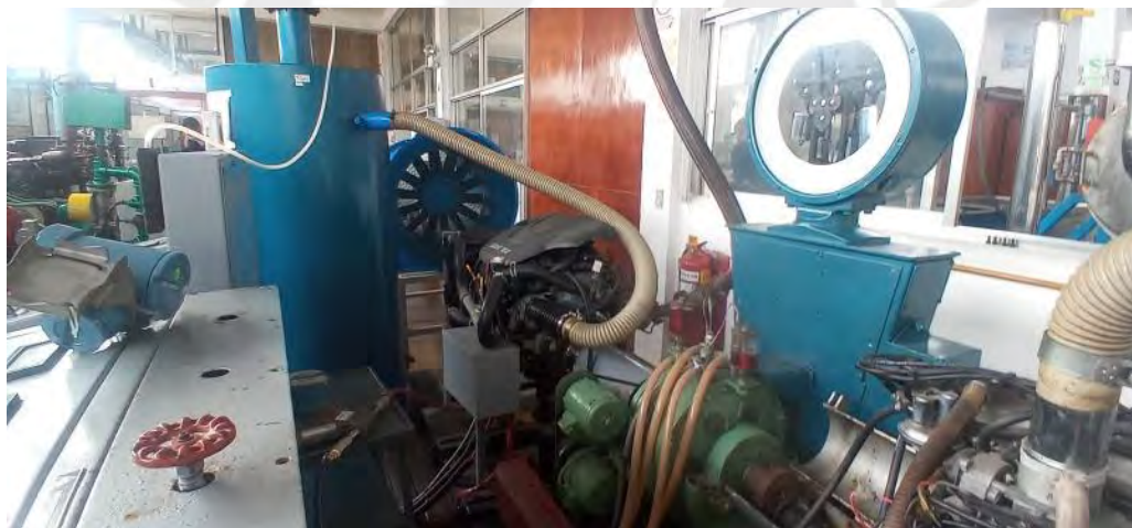
Figura 25 - Vista General del medidor de flujo de aire y banco de prueba del motor.
