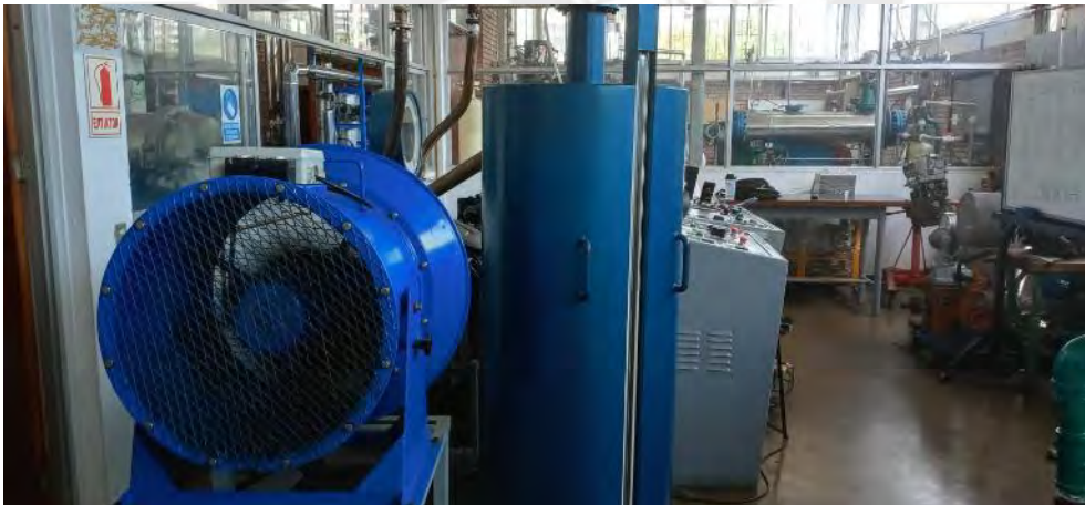
Figura 31 - Ventilador para regular la temperatura del motor en banco de pruebas.
