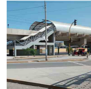
G Paradero de Mototaxis: Exterior de cementerio El Ángel, Puerta Estación El Ángel. Fotografía propia, marzo 2023.
