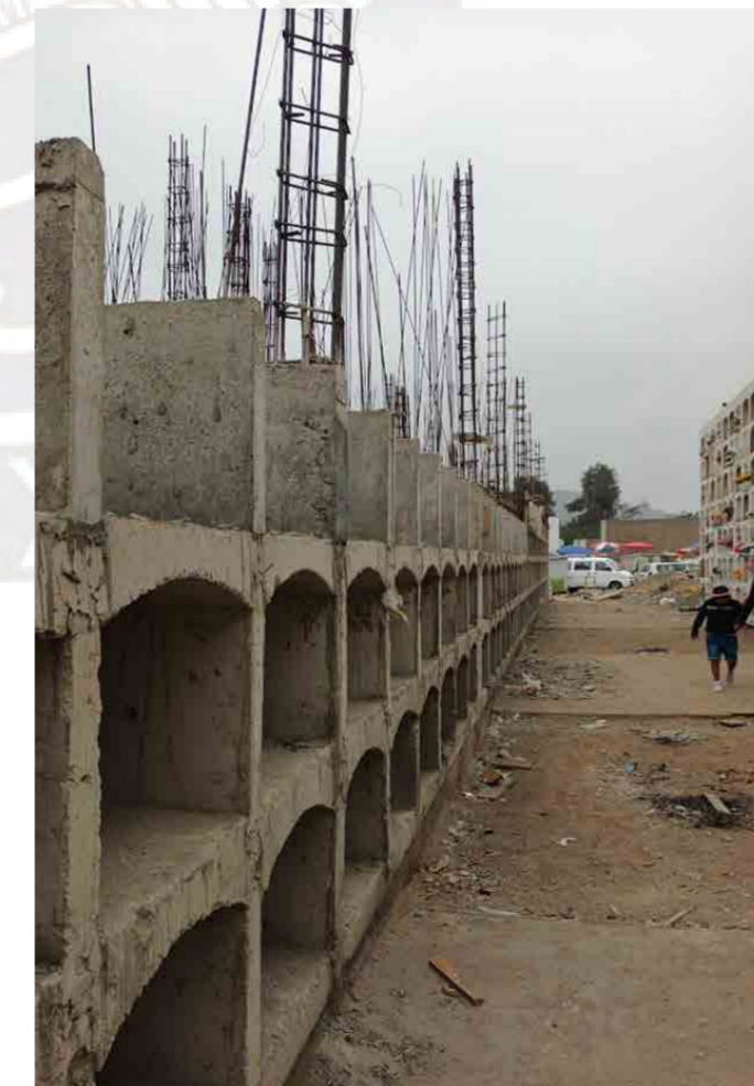
A Construcción de nuevos pabellones de nichos en antigua zona de ceremonia pre-entierro. Fotografía propia. Noviembre, 2023
