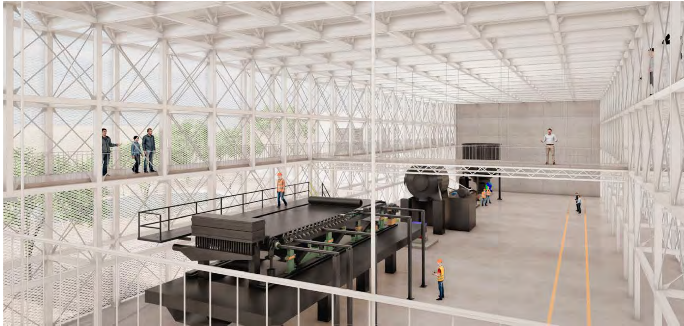
Vista interior del bloque industrial desde la pasarela. En el primer nivel se ubica el área de trabajo, con las máquinas dispuestas a un lado para dejar libre la circulación de montacargas. A los 6 metros de altura, pasarelas suspendidas permiten el recorrido de los visitantes, mientras que a los 9 metros, una pasarela exclusiva facilita el acceso del personal. La estructura abierta y la fachada de malla expandida favorecen la iluminación natural y la conexión con el exterior, en contraste con los entornos cerrados de las infraestructuras industriales convencionales.
