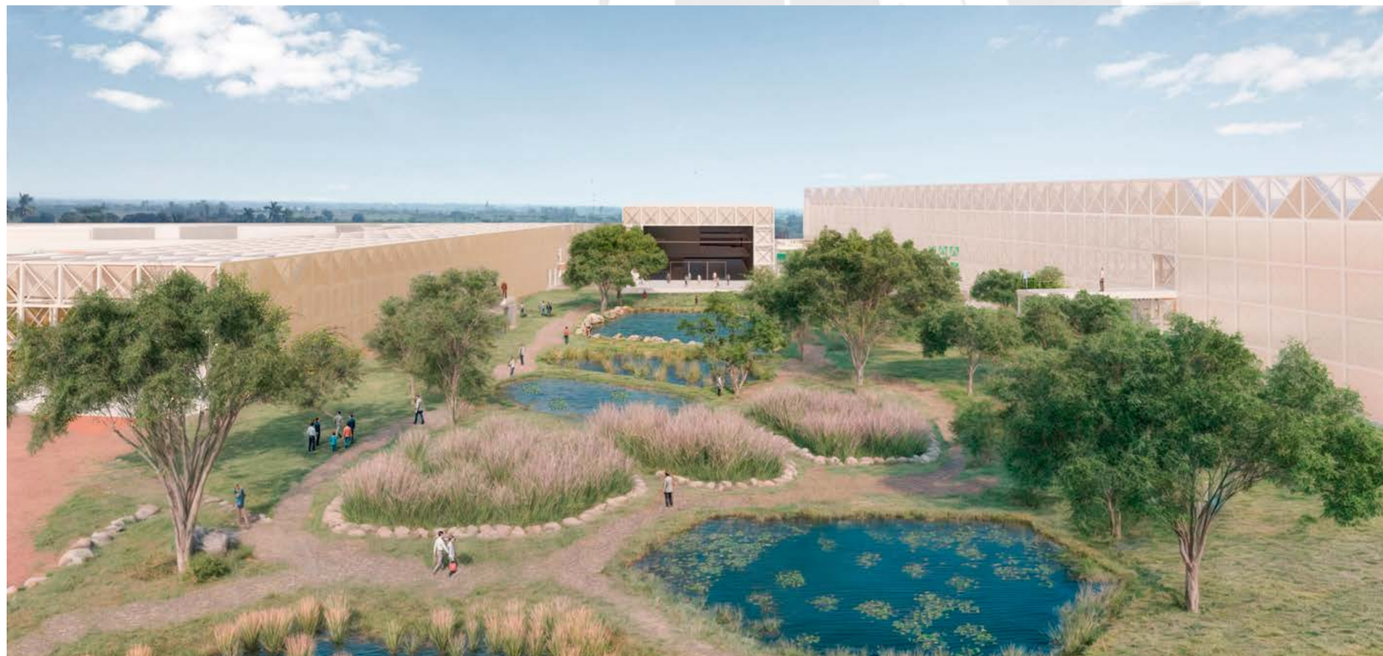
Vista de la zona de humedales para la remediación del agua. Ubicada entre los galpones industriales, esta área actúa como una zona intermedia que equilibra el entorno. Su función es tratar el agua para reintroducirla en un circuito cerrado que abastece al edificio, contribuyendo al cuidado de este recurso. La vegetación de bosque seco remedia el suelo sin competir con las especies acuáticas. La imagen presenta tres planos: primero, la zona natural de humedales y bosque seco; luego, el edificio; y al fondo, la zona urbana de Chiclayo. Además, este espacio se ofrece como una zona de recreación accesible tanto para los trabajadores como para la comunidad.
