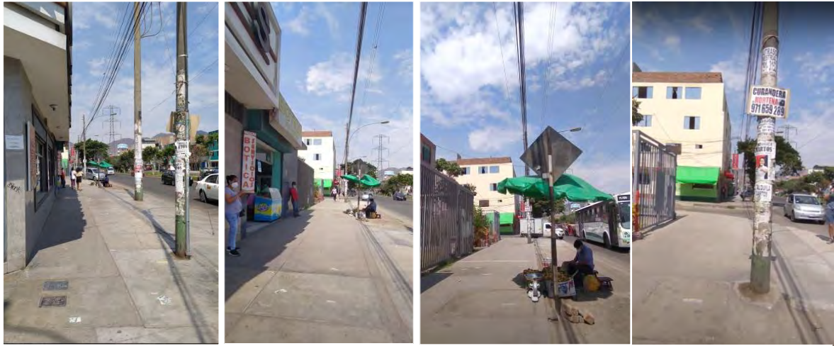
Figura 4.19: Ruta 3. Obstáculos permanentes en la vía que interrumpe el espacio de circulación Fuente: Propia.
