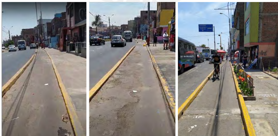
Figura 4.13: Ruta 2. Ciclovía en los laterales de la calzada con flujo unidireccional de bicicletas Fuente: Propia.
