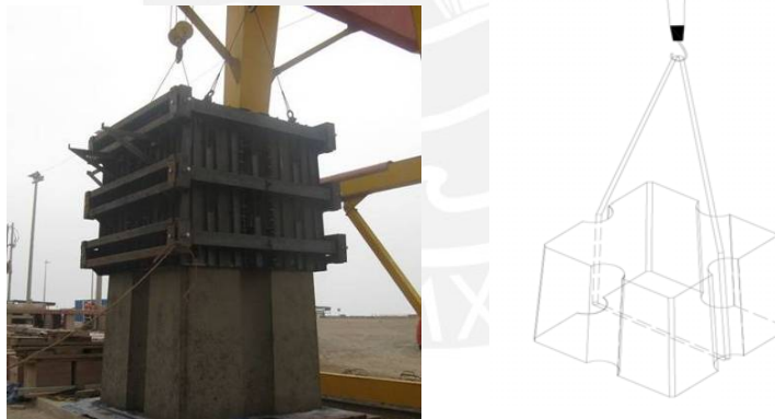
Figura 17: Desencofrado e izaje de BCR
