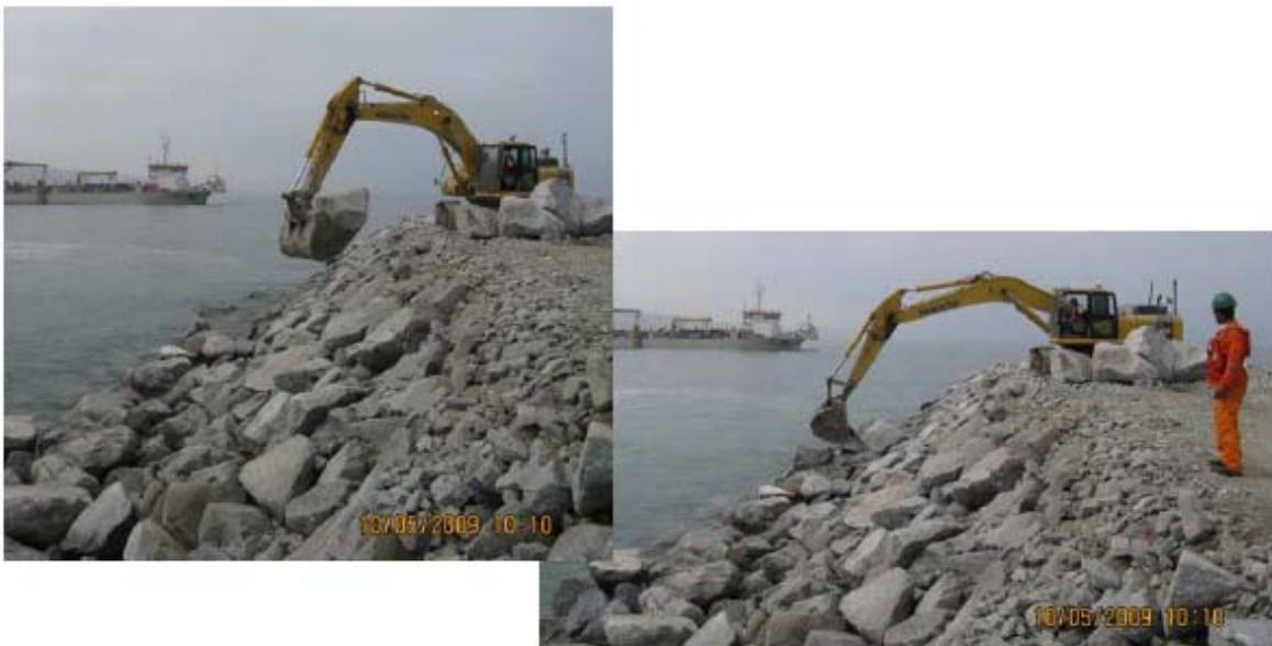
Figura 27: Colocación del material de la capa de protección
