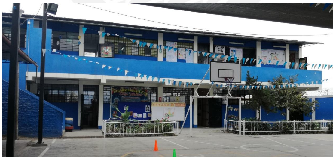
Figura 4.3. Vista frontal del pabellón A de la I.E. N° 7219 Aristóteles [62]
