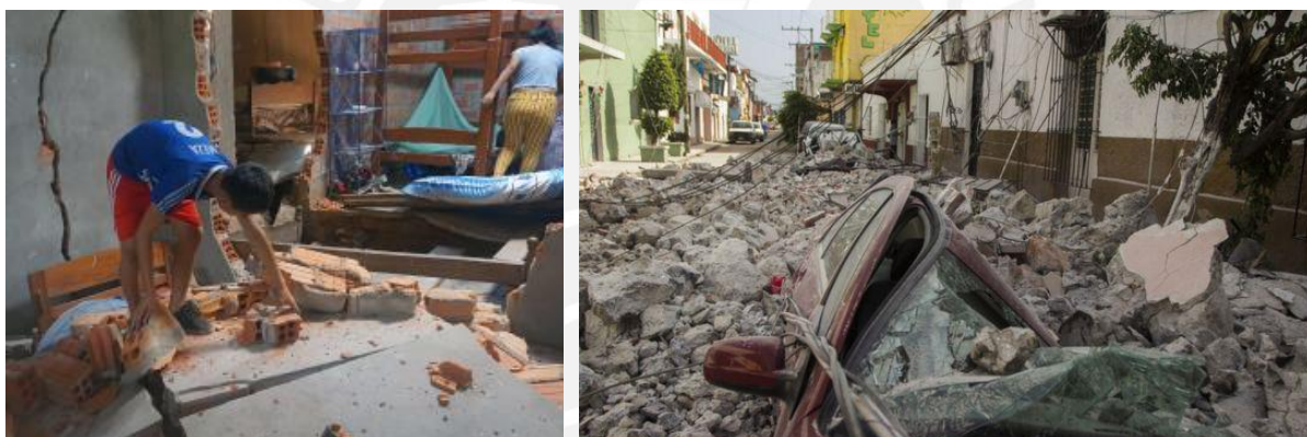
Figura 3.2. Remoción de escombros post sismo (Fuente: INDECI)
