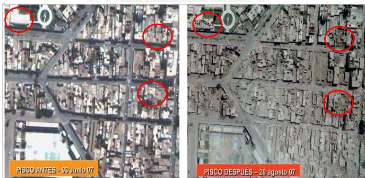
Figura 2.7. Daños directos después del sismo de Pisco 2007 [48]
