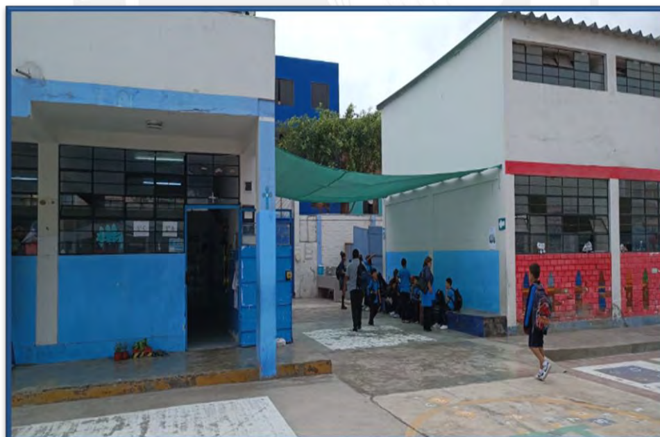
Figura 8. Instalaciones de la IE N° 7034 Enrique Nerini Collazos.
