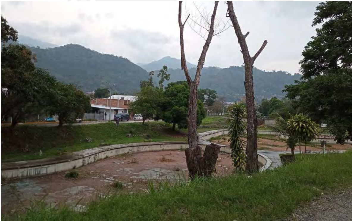
Figura 67: Fotografía del estado actual de la piscina municipal
