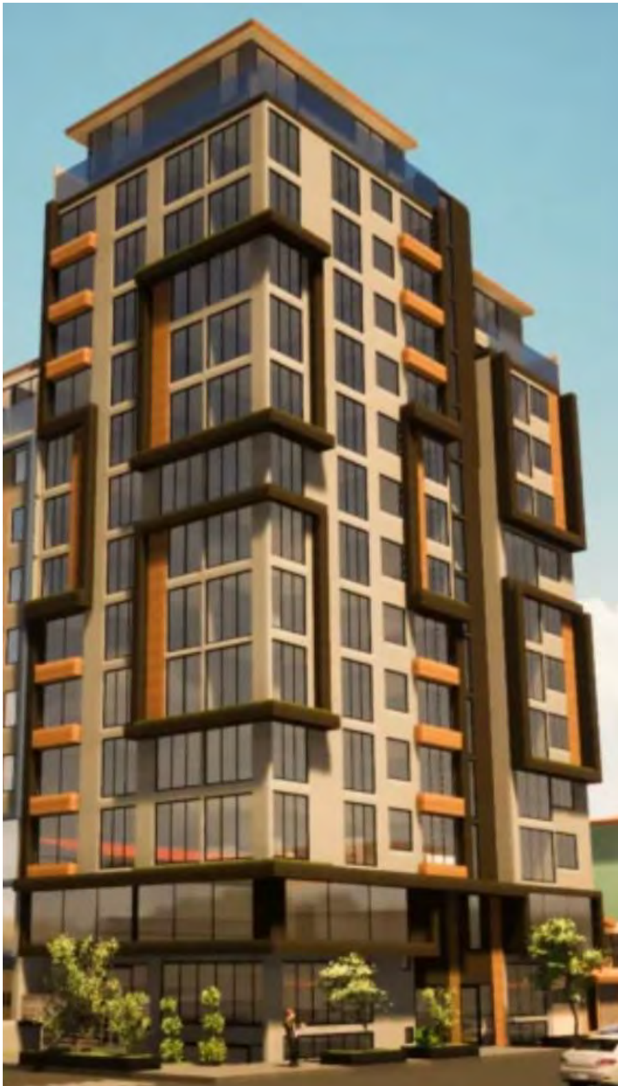
Fachada del edificio multifamiliar Residencial Kreta
