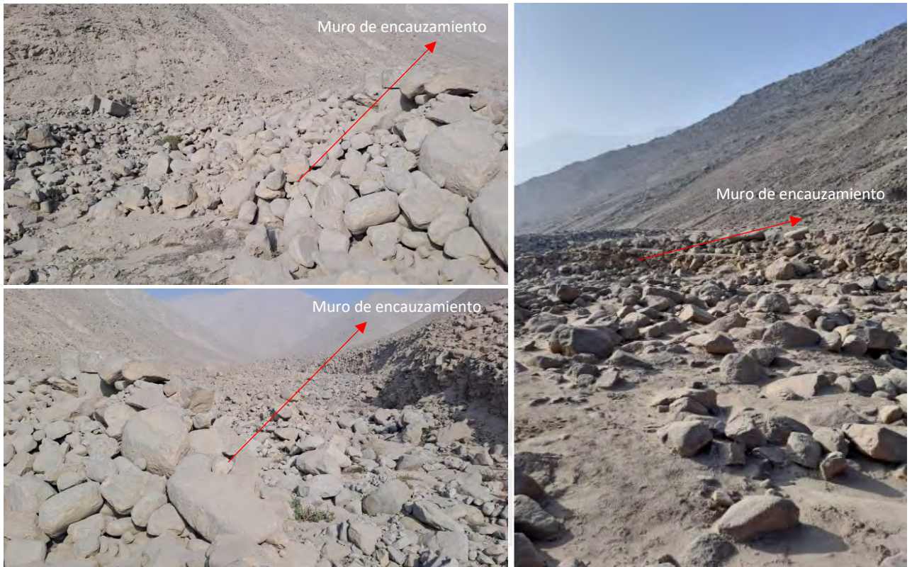
Figura 13. Fotografía del Muro de encauzamiento sin reforzamiento
