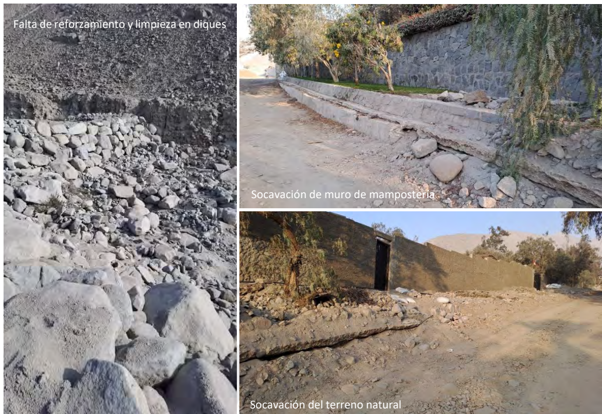
Figura 15. Fotografías del estado actual de las estructuras existentes en el área de estudio
