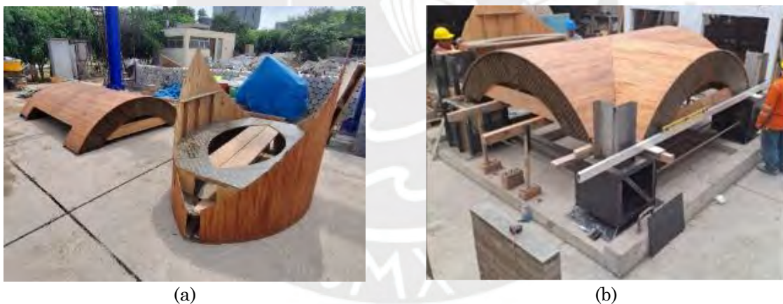
Figura 25. Encofrado fenólico: (a) partes del encofrado fenólico de tres piezas, (b) instalación del encofrado
