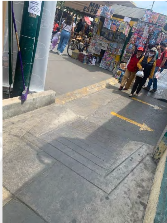
Figura 12 Rampa de acceso de la zona peatonalizada al mercado de Magdalena
