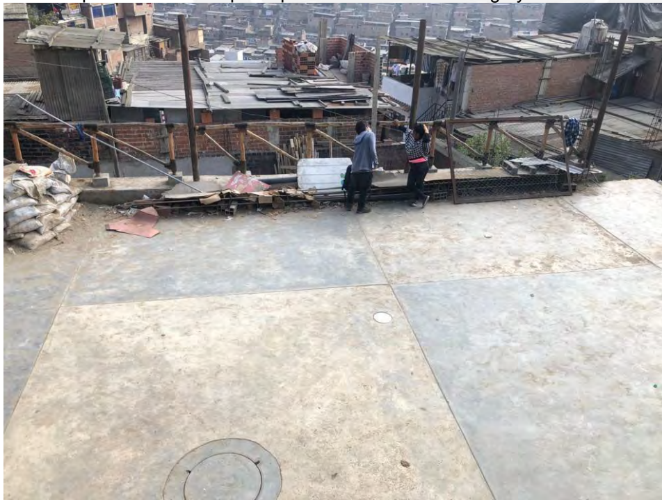
Figura 11 Baranda provisional hecha por la población en zona de riesgo y de uso intensivo II
