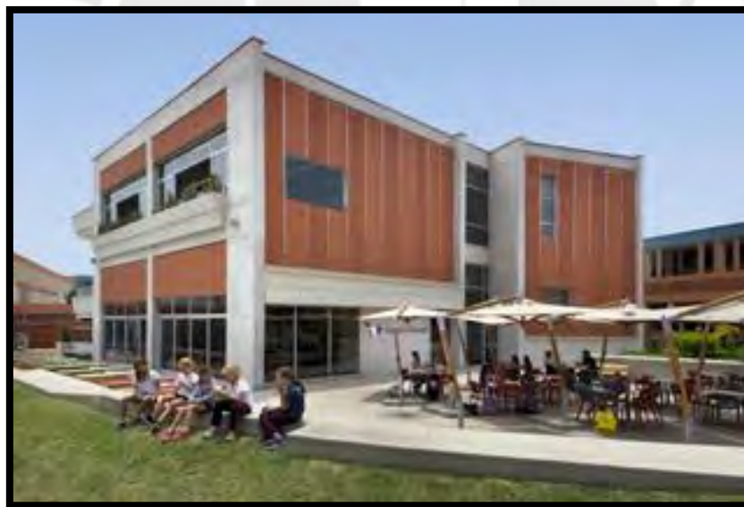
Figura 2: Edificio Roosevelt The Commons, Colegio Roosevelt
