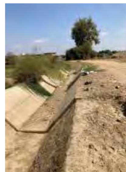
Acequia aledaña en construcción
