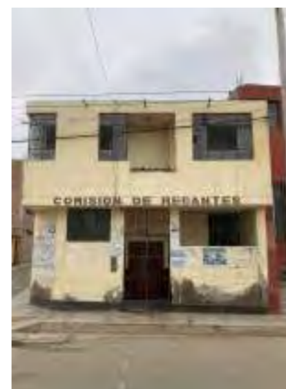
Estado actual de la sede de la Junta de Regantes
