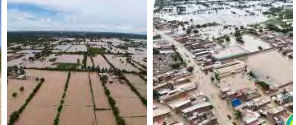
Las obras en ribera de permanencia o temporales son ineficientes por no contener el crecimiento del cauce y agravar la erosión del suelo, sobretodo en zonas críticas cercanas a caseríos. En consecuencia, el desborde del río la Leche causa la inundación del centro poblado y zonas agrícolas cada FEN.
