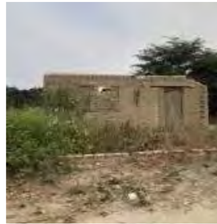
La vivienda de adobe
