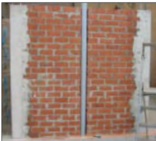
Figura 3.12: Muro picado para colocar tubería (San Bartolomé et al., 2006)
