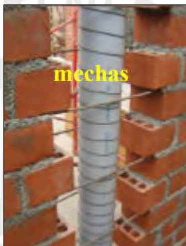
Figura 3.13a: Conexión dentada y mechas para colocación de tubería (San Bartolomé et a, 2006)
