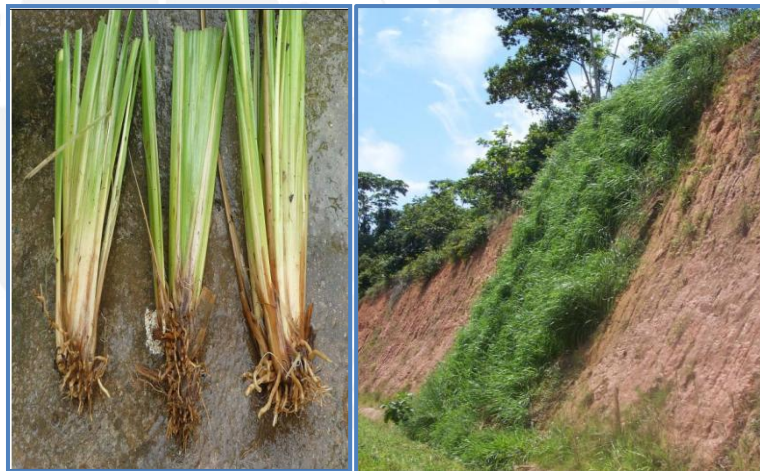
Figura A15-01: Izquierda: Esquejes de Vetiver. Derecha: Vetiver en su primer año de crecimiento (Carretera Iquitos – Nauta)
