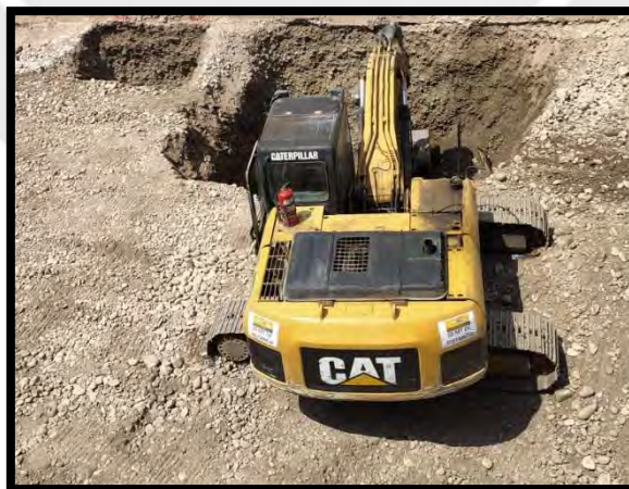
Figura 19: Excavación de banqueta.
