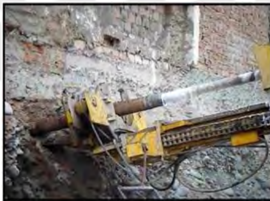
Figura 8: Perforación del muro anclado.
