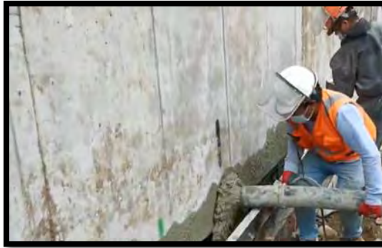
Figura 23: Vaciado del muro anclado.
