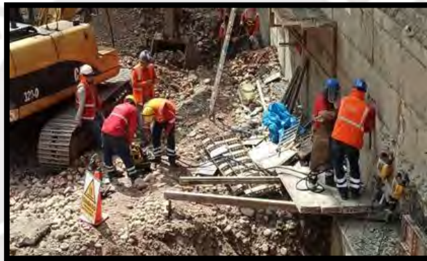
Figura 24 Tensado del muro anclado.
