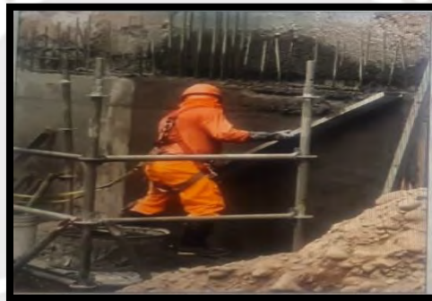
Figura 59: Enlucido del muro.
