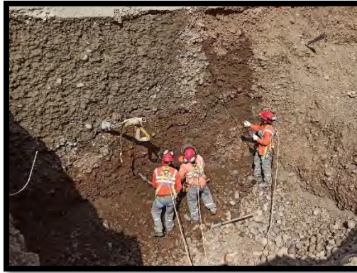
Figura 20: Perfilado y pañeteo.
