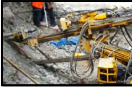
Figura 17: Perforación del muro anclado.
