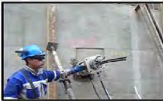
Figura 16: Tensado del muro anclado.
