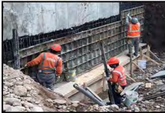
Figura 13: Encofrado del muro anclado.
