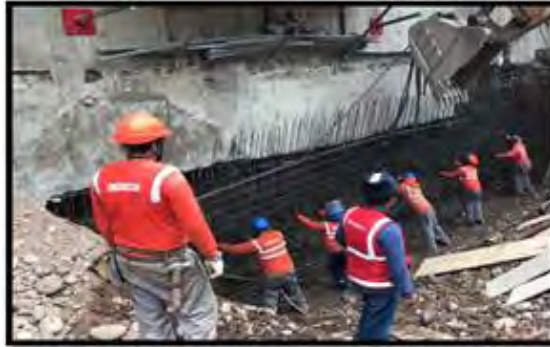
Figura 12: Acero del muro anclado.
