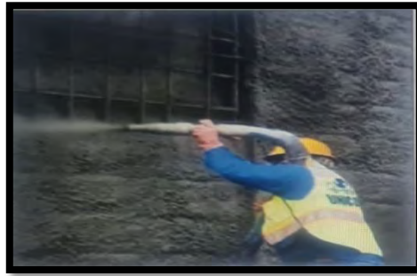
Figura 58: Proyectado de concreto.
