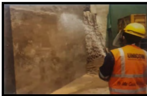
Figura 60: Curado del muro.
