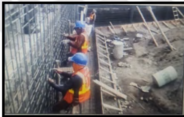
Figura 54: Acero de muro con sus respectivos anclajes.
