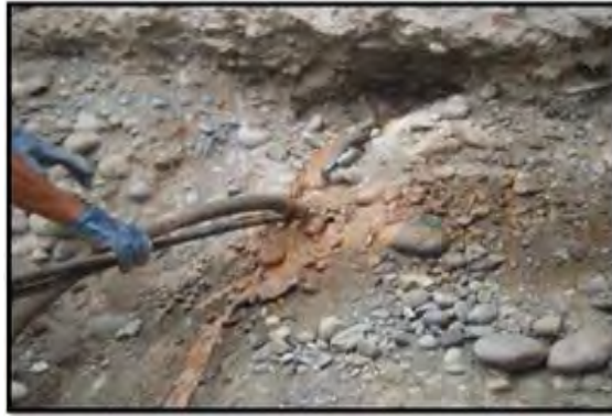
Figura 9: Inyección de lechada. Fuente propia.
