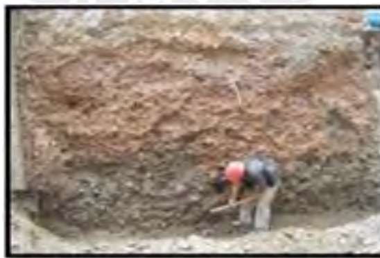
Figura 11: Perfilado y pañeteo. Fuente propia.
