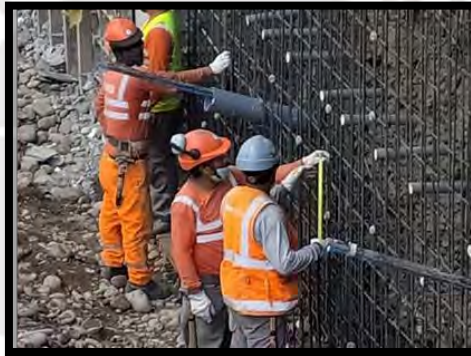
Figura 21: Acero del muro anclado.
