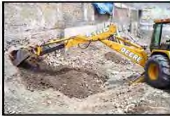
Figura 10: Excavación de banqueta. Fuente propia.
