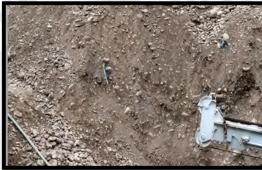
Figura 18: Inyección de lechada.
