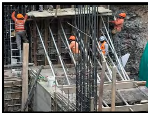
Figura 22: Encofrado del muro anclado.
