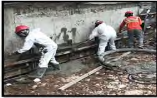
Figura 15: Vaciado del muro anclado.
