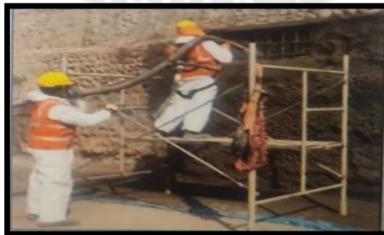
Figura 57: Instalación de plástico en la parte inferior y andamio.
