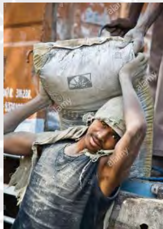
Figura 1.2. Descarga de bolsas de cemento.
