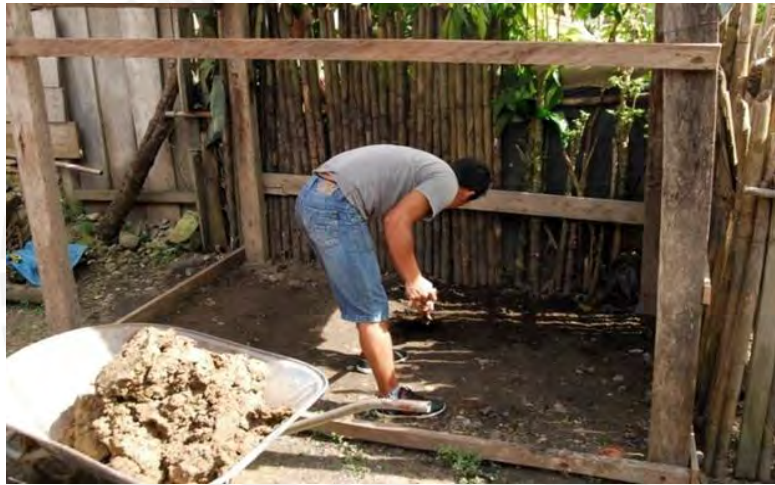
Fotografía N° 7 Nivelación del piso
