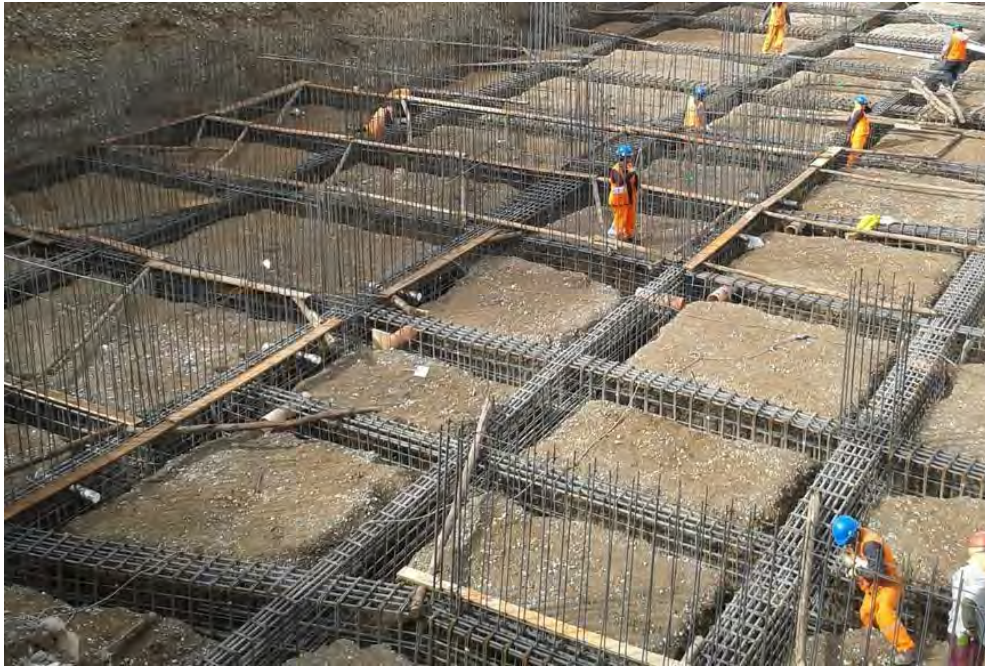
Figura 2.20. Emparrillado. Fuente: https://victoryepes.blogs.upv.es/2019/01/15/emparrillados-de-cimentacion/
