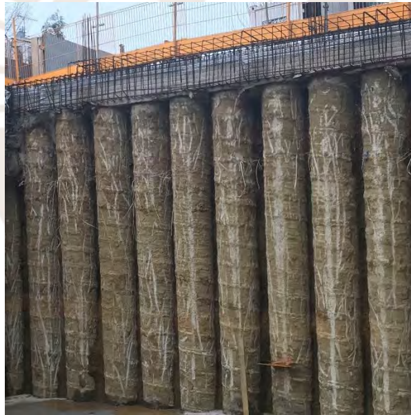
Figura 2.4. Muro de pilotes. Fuente: https://www.archiexpo.es/prod/franki-foundations-belgium/product-61404-2159903.html
