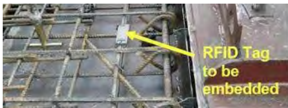
Figura 22. Chip RFID en el armado antes de ser vaciado con concreto.
