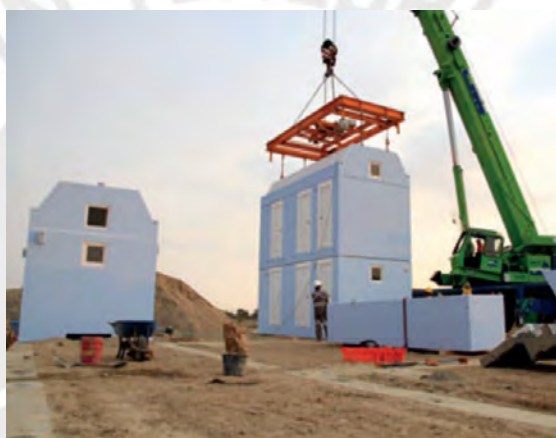
Figura 9. Montaje de las viviendas modulares.
