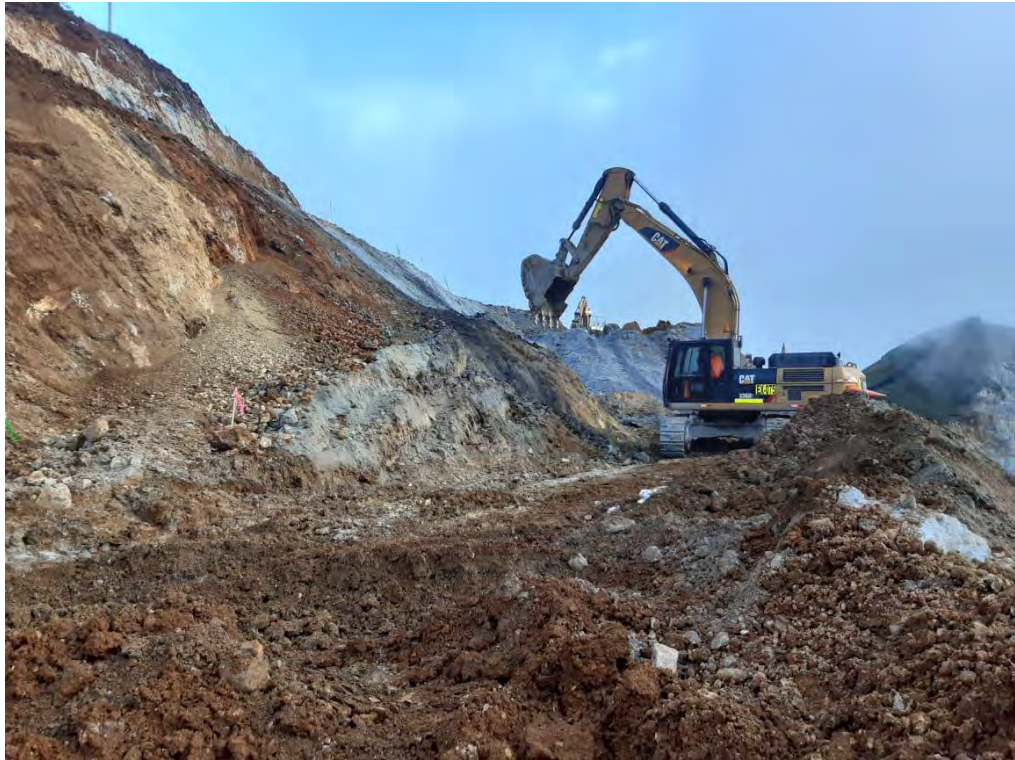
Figura 44. Corte maría cerro sin voladuras
