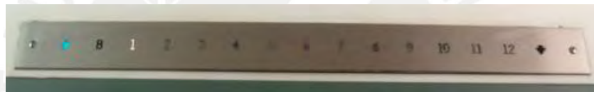
Figura 2.9.- Indicadores en ascensores antiguos. Fuente: Propia
