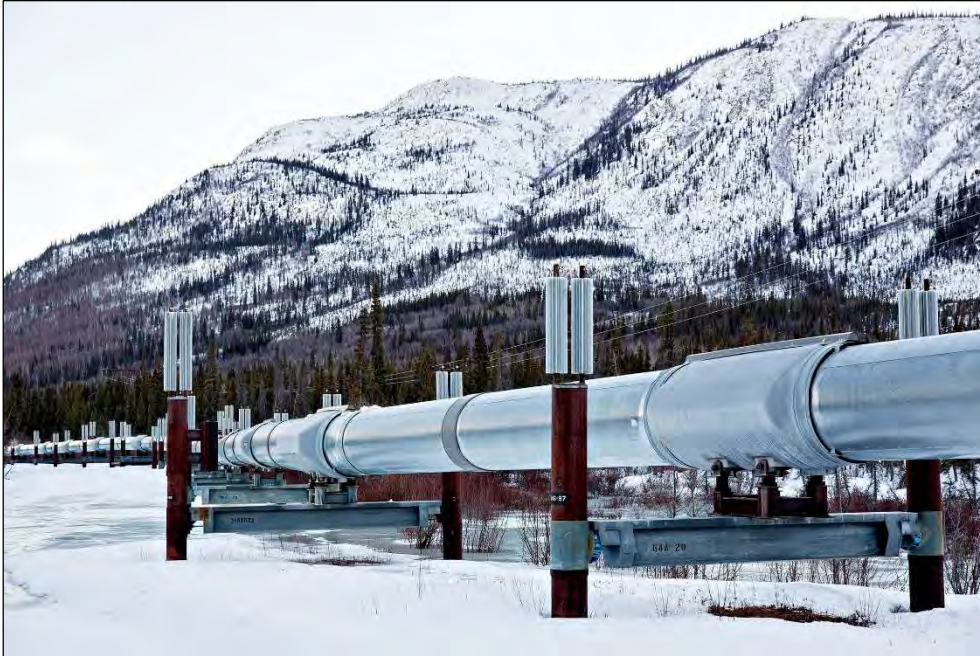
Figura 1.2. Oleoducto TransAlaska manufacturado con acero HSLA
