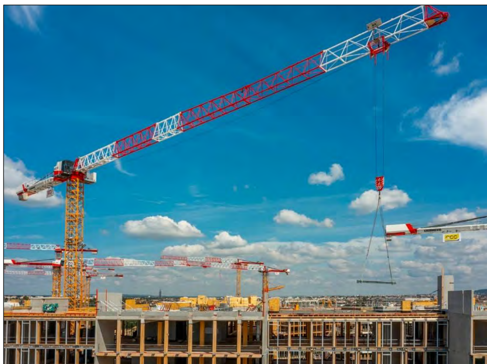
Figura 1.7. Grúa pluma emplea acero HSLA en su manufactura
