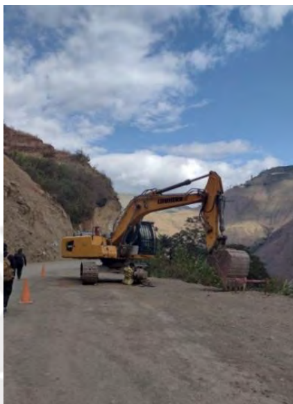
Foto 6.21. Excavadora en la carretera Nuevo Tingo-Kuelap
