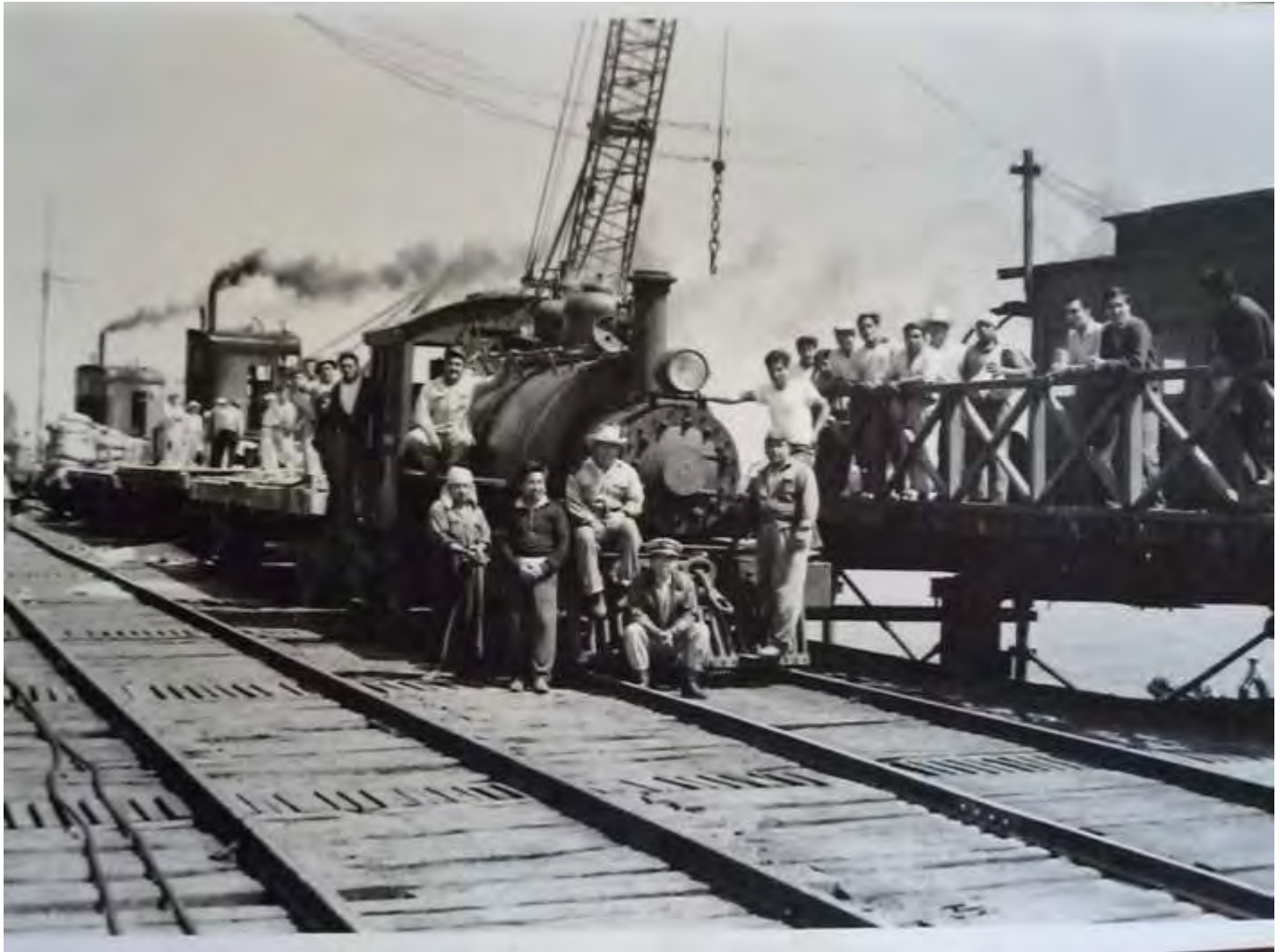
Figura 14 Frente a la oficina del muelle de Eten, locomotora N°9 efectuando operaciones de embarque de azúcar a granel para el vapor Kanishka Jayanti, 1966. Nota. De colección particular Sánchez Razuri.
