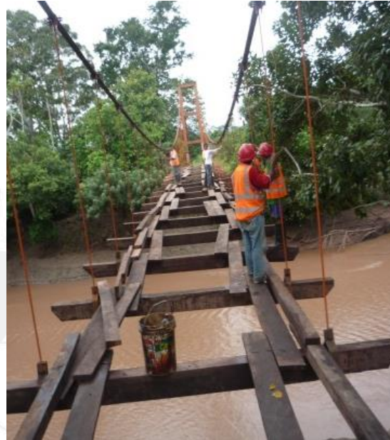
Puente de madera en la Q. Chipaota
