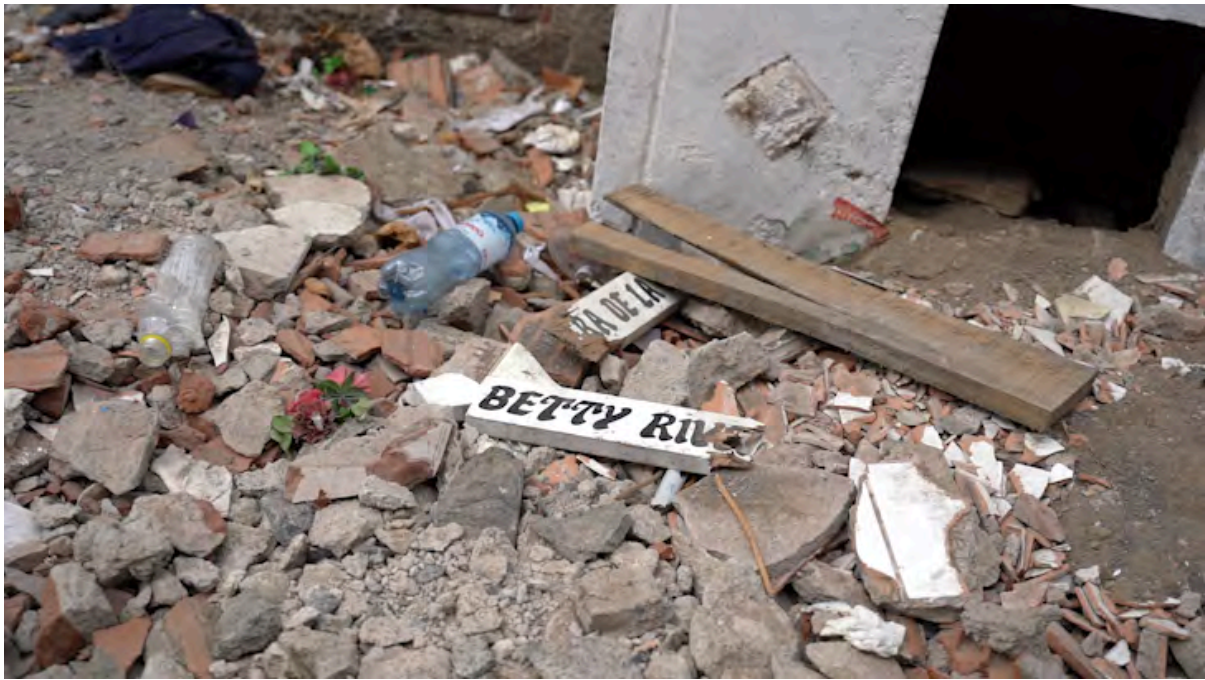
Fotos 22 y 23: Imágenes registradas del estado material precario del cementerio
