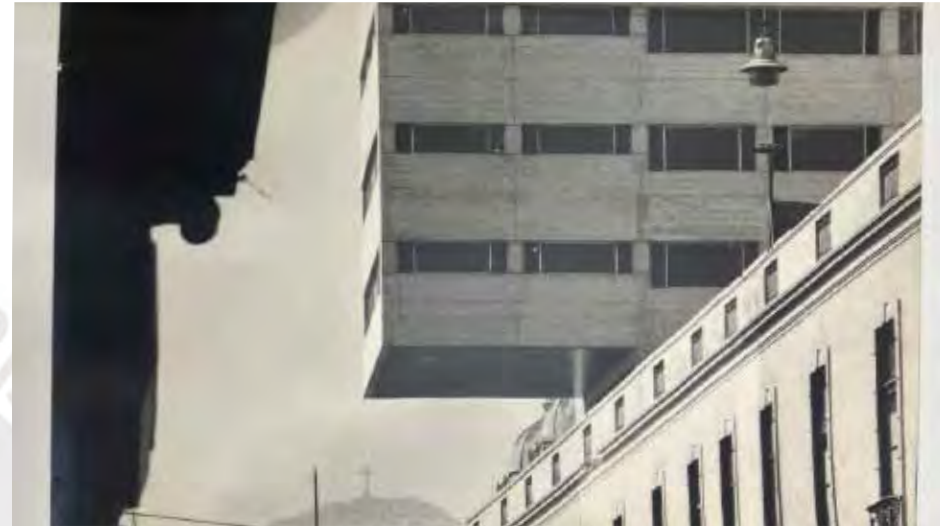
[Figura 1] Fotografía de sección donde se ubican las vigas Viarendel que sostienen el volado Fuente: Archivo de Arquitectura PUCP (1976)
