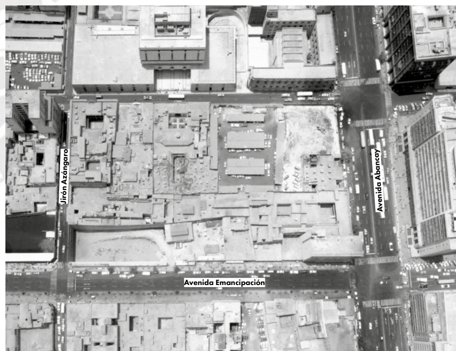
[Figura 1] Vista aérea después del ensanche de las vías Fuente: Servicio Aerográfico Nacional (1976)
