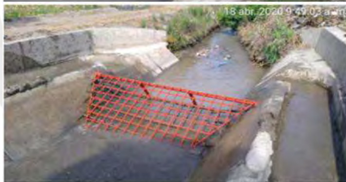
Limpieza de sifón - 100 metros aguas arriba en la Progresiva: km 198+700 al 198+700 sentido Sur/Norte, Tramo 03
