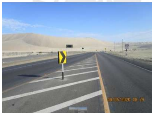
Señalización Vertical, elementos faltantes Km 369+650 (09 chevrones faltantes) – Fotos Antes y Después
