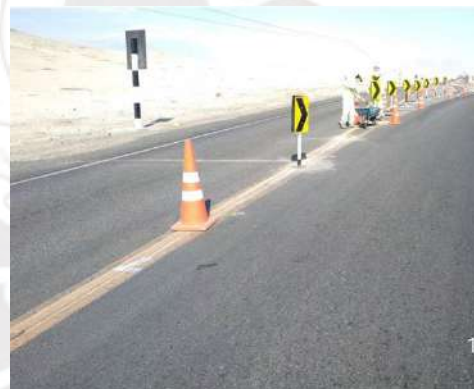
Señalización Vertical, elementos faltantes Km 369+650 (09 chevrones faltantes) – Fotos Antes y Después
